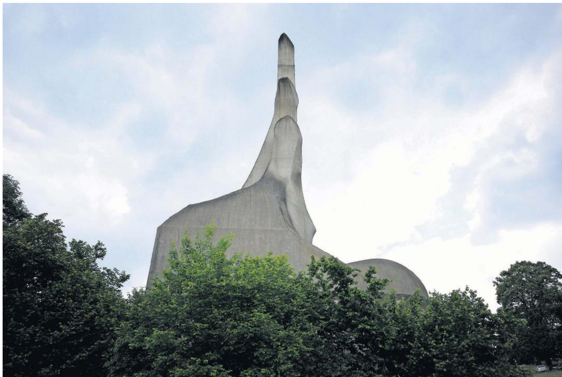
Der markante Zacken-Kamin des Heizhauses (1914). In dieses Gebäude ist
